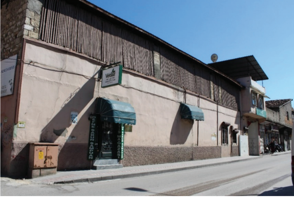
G. 19: Selahattin Ökten Sabunhanesi Batı Cephesi (Çiftyürek, 2017)
