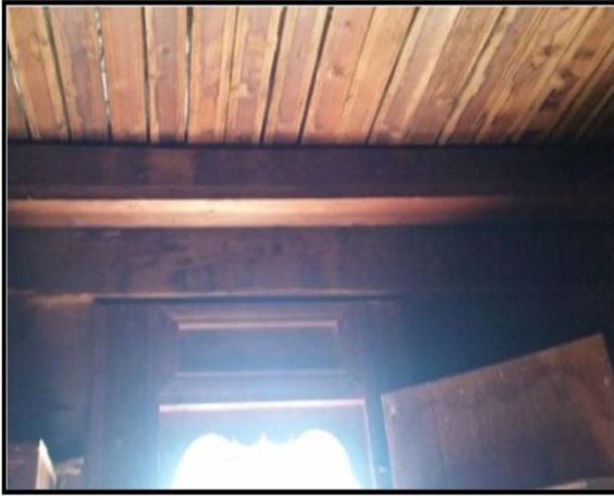
Şekil 12. Izgara Sistemi ile Yapılan İç Hayat Tavanı
