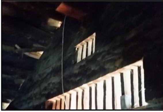
Şekil 8. Ahşap Yığma Sistemi ile Yapılan Konutların Havalandırma Boşlukları
