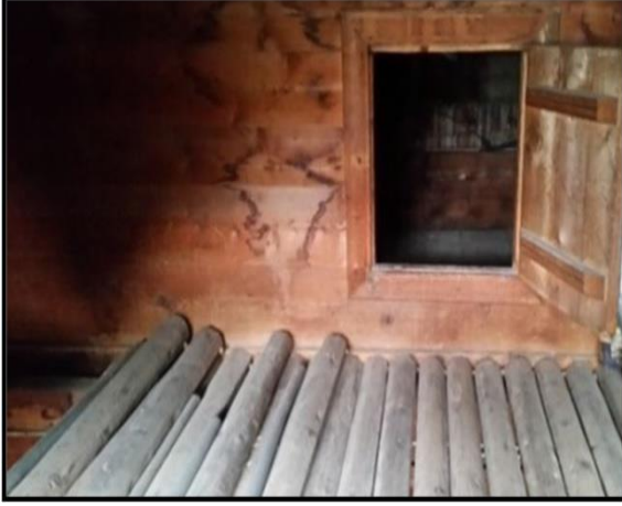
Şekil 15. Izgara Sistemi ile Oluşturulan Serander Döşemesi
