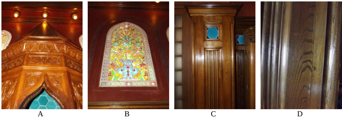
Şekil 5. A- Yemek salonu şömine ve ahşap oyma süslemeli külahı, B- Yemek salonu vitray (Revzen) pencere, C- Yemek salonu turkuaz çinili ahşap lambri detayı, D- Yemek salonu lambri malzemesi: karaağaç ahşap.
