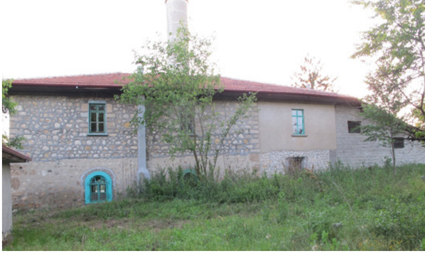
Foto. 2- Doğu Cephe, Genel Görünüm
