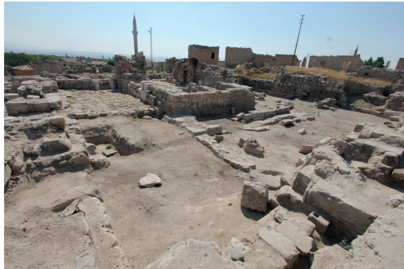
Resim 6. Piskoposluk kilisesinin kuzeybatıdan görünümü
