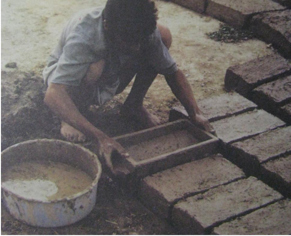
Resim-16 Kalıp yapımı kerpiç. (Roaf, 1996)
