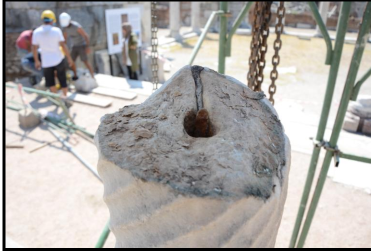
Res. 12: 1963 yılı hatalı kurşun sabitleme uygulaması ve işlevini yitirmiş, pul pul olmuş polyester esaslı yapıştırıcı sütun gövdesi üst yarısı kaldırıldıktan sonraki görünümü (Kazı Arşivi).
