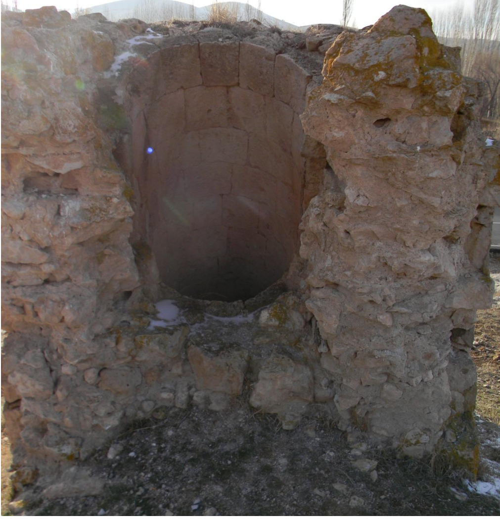
Resim 12: Keler Değirmeni kapalı oluğu duvar örgüsü görünüşü.
