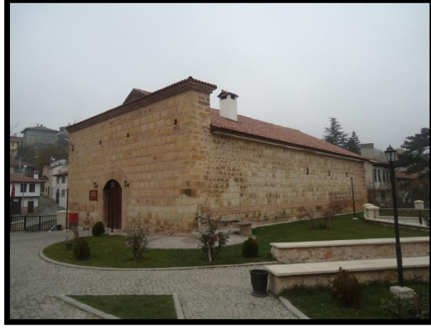
Şekil 4. Restorasyon sonrası Deve Hanı'nın görünümü.
