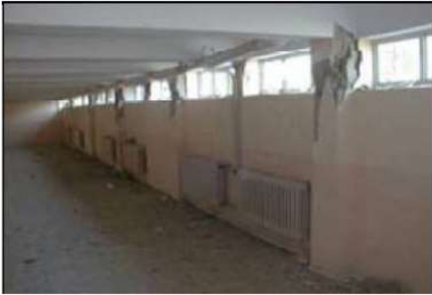
Şekil 12. 1999 Düzce depreminden sonra bir okulda gözlenen kısa kolon hasarları (İrfanoğlu (2009)).
