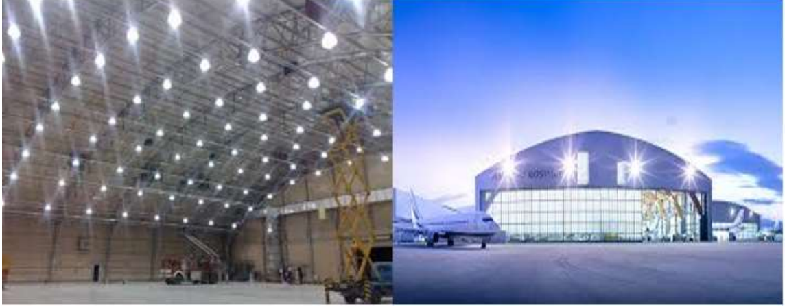
Şekil 6. Uygun Işık Kaynağı, Zemin ve Çatı Dizaynı ile Aydınlatılmış Uçak Bakım Hangarı
