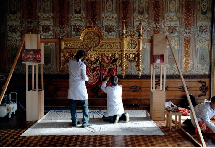
Resim 5: Dolmabahçe Sarayı Süferâ Salonu restorasyon çalışmaları
