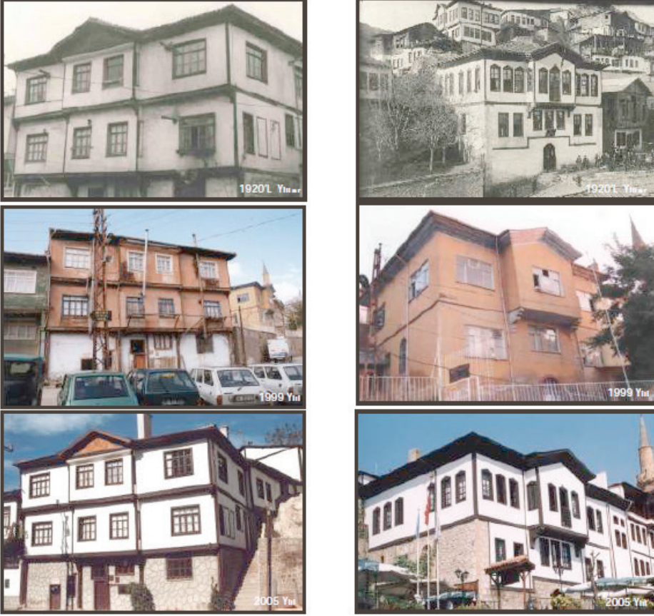
Fotoğraf 7: Cephe makyajı onarımı
