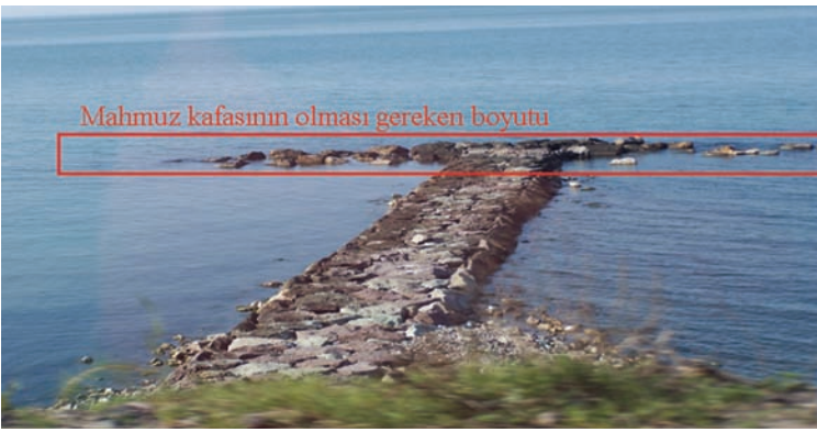
Şekil 7: Bir mahmuzun deniz etkileri sonucunda karakteristik özelliklerini yitirmesi.
