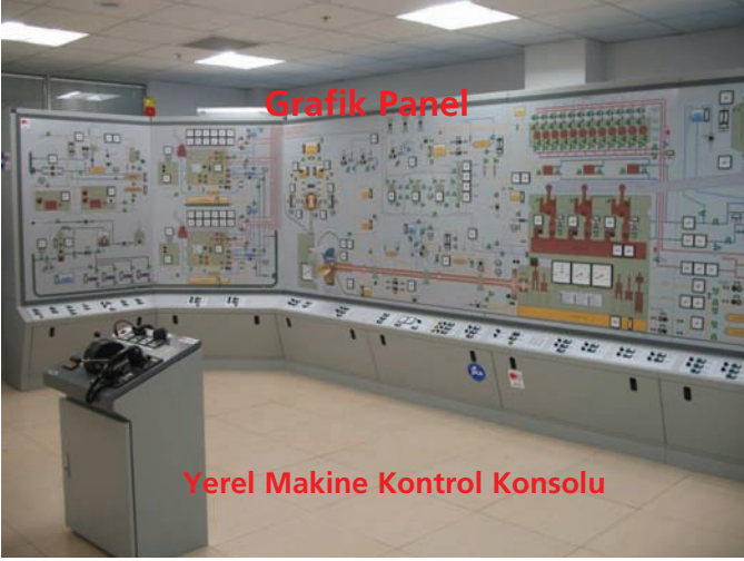
Şekil 3: Makine Dairesi Grafik Paneli
