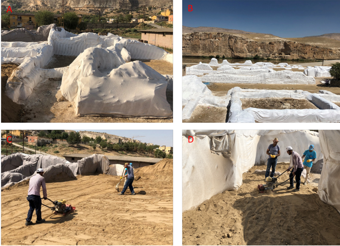
Resim 20. Mardinike Külliyesi Yapı Kalıntılarının Su Altında Korumasına Yönelik Uygulamaları, Resim 20A-20B: Jeotekstil Keçe Kalıntıların Yüzeyine İki Kat Olarak Serilmesi Uygulaması, Resim 20C-20D: Tabakalar Halinde Doldurulan Koruma Dolgu (Mil Kumu) Uygulaması (Yazar Arşivi)
