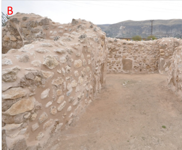
Resim 15. Mardinike Külliyesi Yapı Kalıntılarının Duvar Örgülerinde Derz Onarımları, Resim 15A. Derz Onarımları Uygulamaları, Resim 15B. Derz Onarımları Uygulamaları Sonrası (Yazar Arşivi)
