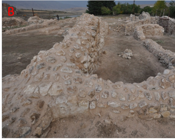
Resim 14. Mardinike Külliyesi Yapı Kalıntılarının Üzerine Capping (Harpuştalama) Yapılması, Resim 14A. Capping (Harpuştalama) Yapılması Uygulamaları, Resim 14B. Capping (Harpuştalama) Yapılmas Uygulamaları Sonrası (Yazar Arşivi)
