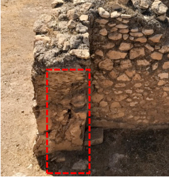
Resim 6. Mardinike Külliyesi Yapı Kalıntılarında Çatlak / Ayrışma Örnekleri (Yazar Arşivi)
