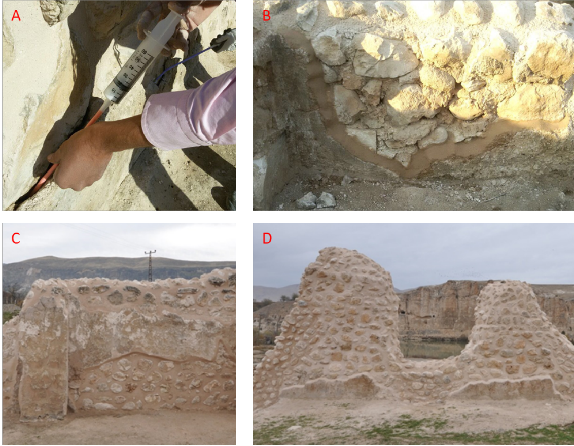
Resim 17. Mardinike Külliyesi Sıva Kalıntılarının Sağlamaştırılması,
