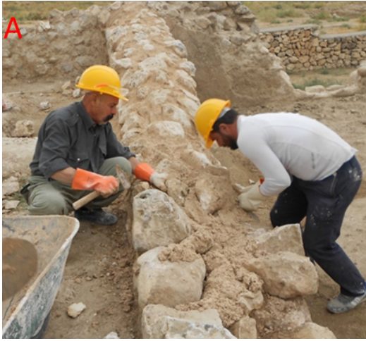
Resim 14. Mardinike Külliyesi Yapı Kalıntılarının Üzerine Capping (Harpuştalama) Yapılması, Resim 14A. Capping (Harpuştalama) Yapılması Uygulamaları, Resim 14B. Capping (Harpuştalama) Yapılmas Uygulamaları Sonrası (Yazar Arşivi)
