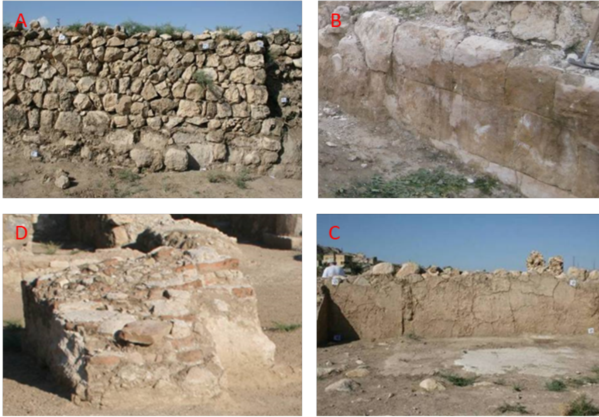
Resim 5. Mardinike Külliyesi, Resim 5A: Moloş Taş Malzeme Kullanımı, Resim 5B: Kesme Taş Malzeme Kullanımı, Resim 5C: Tuğla Malzeme Kullanımı, Resim 5D: Sıva Kullanımı (Yazar Arşivi)
