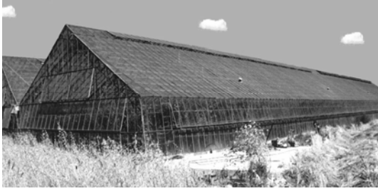
Şekil 1. Bölgede Yaygın Olarak Kullanılan İkizkenar Beşik Çatılı Cam Sera
