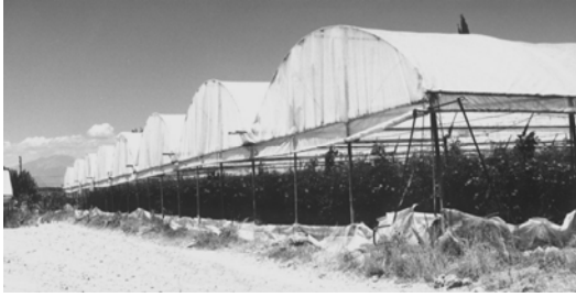
Şekil 2. Bölgede Yaygın Olarak Kullanılan Yay Çatılı Plastik Sera
