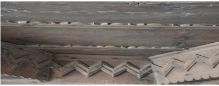
Görsel 18. Bindirmeli tavan pervaz detayı
