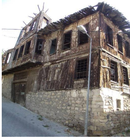
F. 3: Sarı taş üzerinde şamdolma tekniği. (Şirin Yılmaz arşivi. 13 Ağustos 2019)
