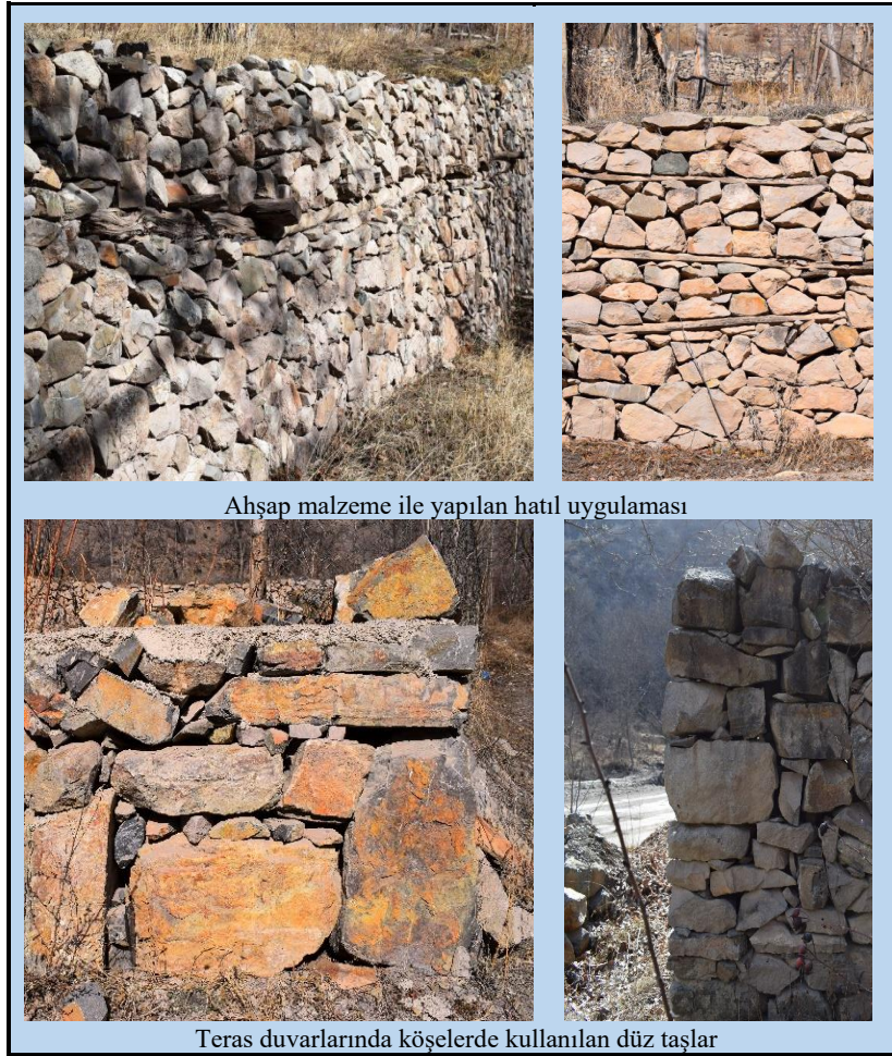
F. 4. Teras duvarlarında hatıl uygulaması
