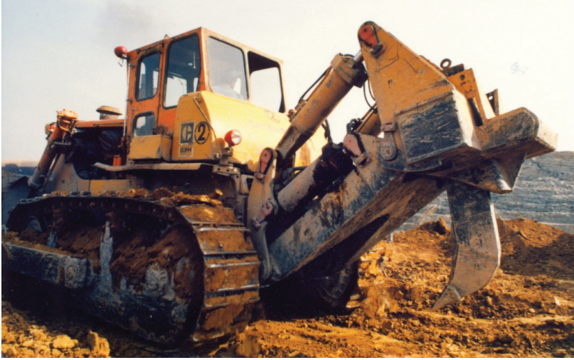
Şekil 1. Örtükazı işlerinde sökme uygulaması
