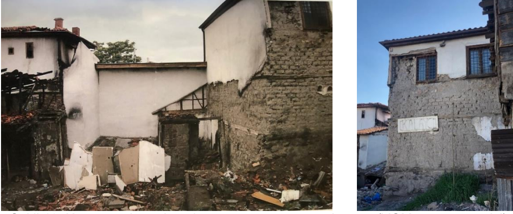
Şekil 10. Kuzey ve doğu duvarlarının yangın sonrası durumu (VGM ve yazar arşivi)
