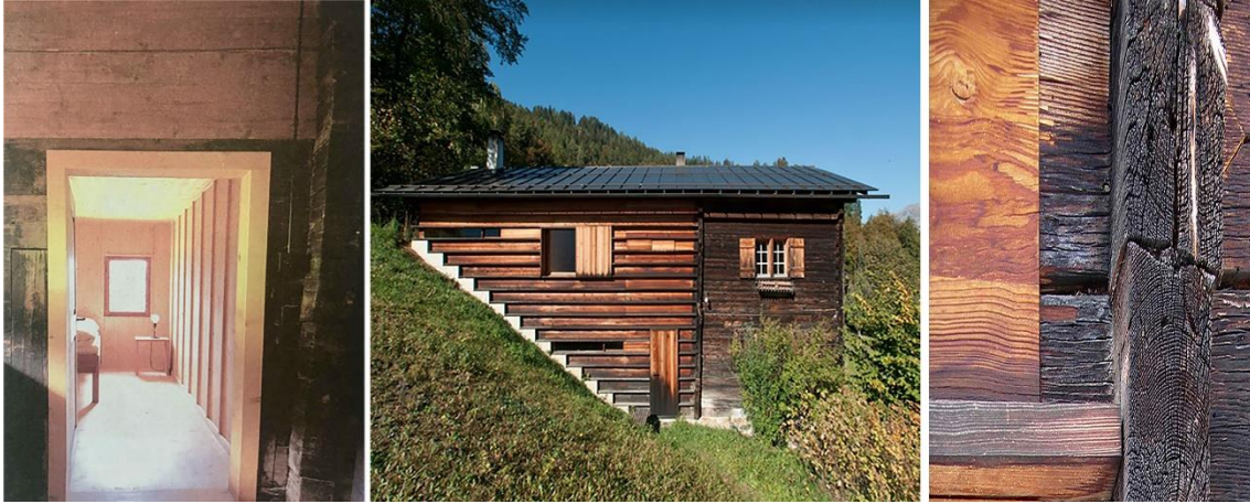
Resim 7. Solda, Gugalun evi içinde eski-yeni eşik. Ortada, yeni kütle ile eski kulübenin teması (Bilgin, 2015). Sağda, işlenmemiş yeni kerestenin eski malzeme ile buluşması (URL-7).
