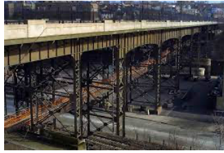
Şekil 25. Marsupial Köprüsü (URL-19)
