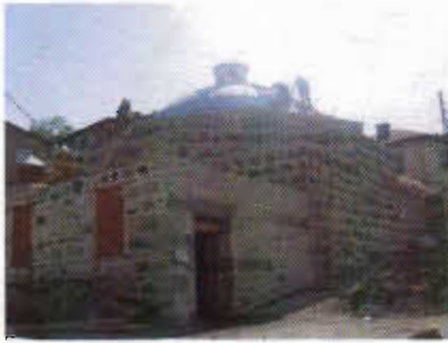
Resim 15: Giriş cephesindeki çalışmaları
