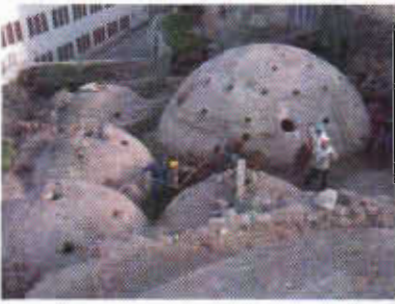
Resim 9: Toprak dolgunun boşaltılması
