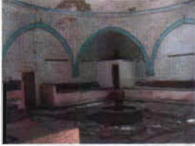
Resim 5: Onarım öncesi soyunmalık
