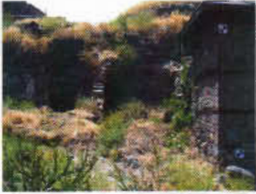
Resim 3: Hamamın onarım öncesi dış görünüşü
