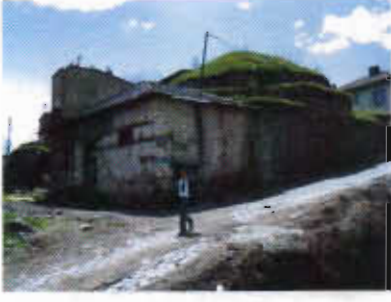
Resim 1: Saray Hamamının onarım görünüşü
