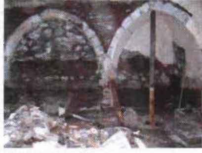
Resim 20: Sıvaların kaldırılışı
