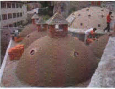
Resim 11: Hamamın kubbelerinin toprakla sıvanışı
