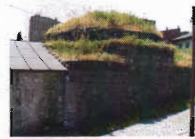
Resim 4: Hamamın onarım öncesi dış görünüşü
