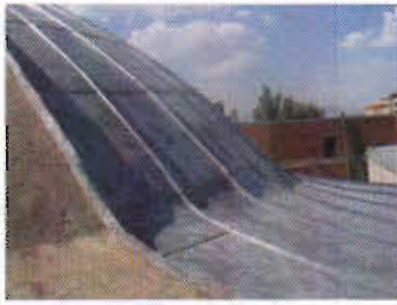
Resim 12: Kubbelerin sac kaplanması
