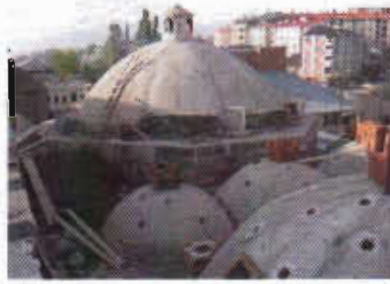
Resim 10: Hamamın örtüsündeki restorasyon
