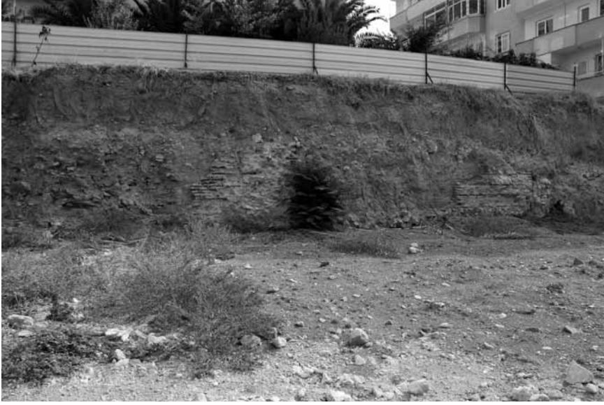
Levha 5.1. III ve IV no'lu duvarlar.
