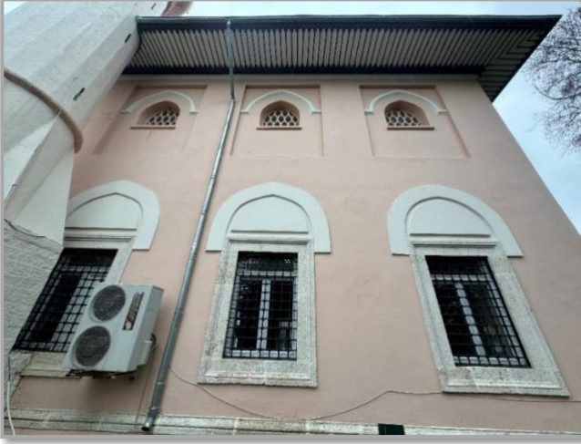
Şekil 8: Caminin Batı Cephesi
