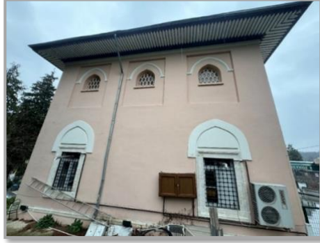
Şekil 6: Caminin Güney Cephesi
