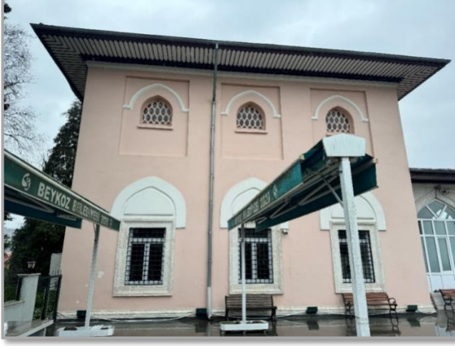
Şekil 7: Caminin Doğu Cephesi
