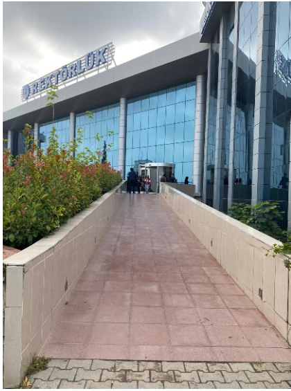
Kütüphane binası giriş rampası
