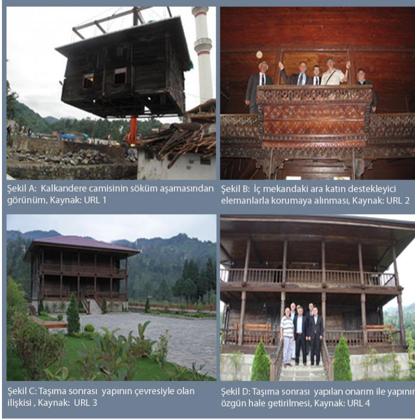
Şekil 1. Kalkandere camisinin taşıma aşamaları
