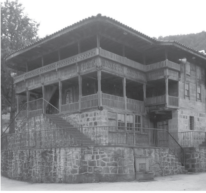
Foto 1: Bilen Köyü Camii Kuzeydoğu Cephe
