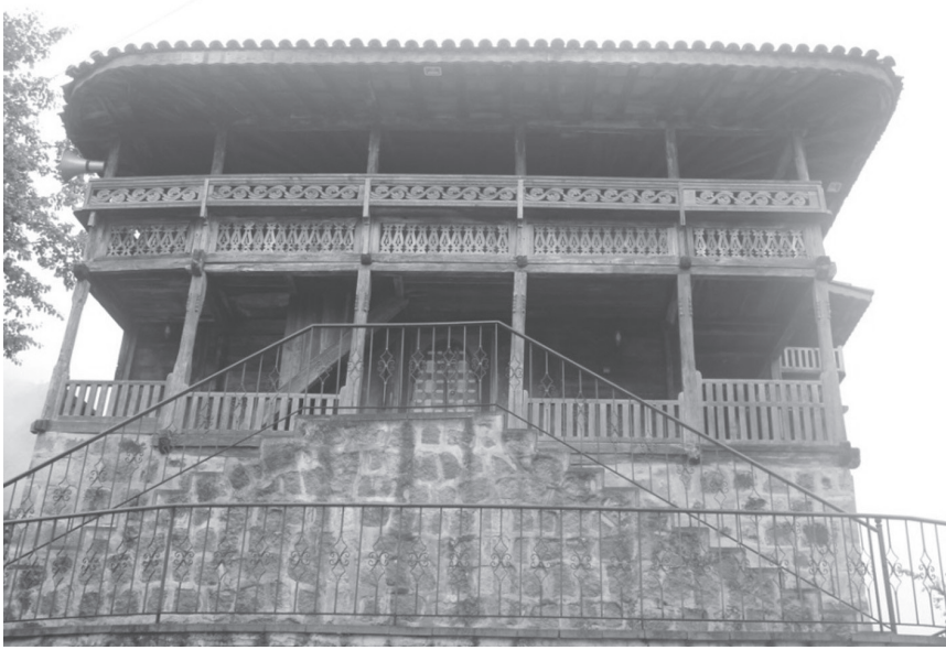
Foto 2: Bilen Köyü Camii Kuzey Cephe
