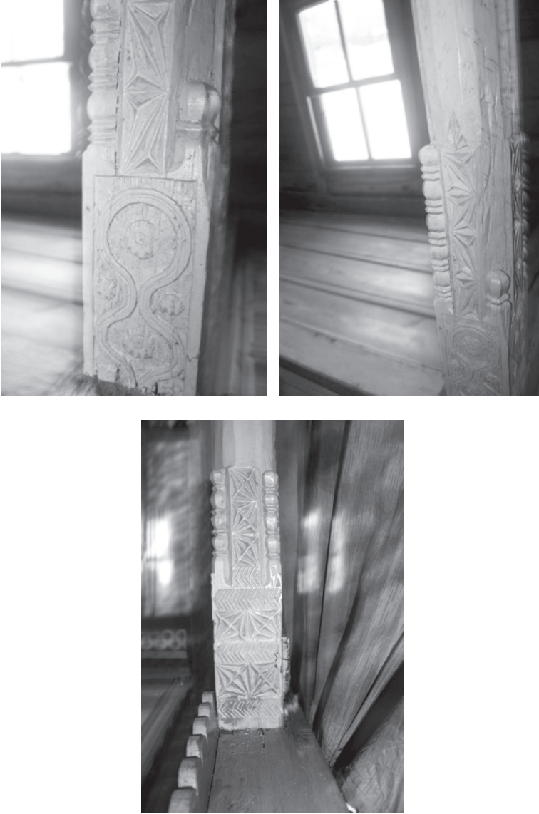
Foto 17-18-19: Mahfilde bulunan Üst Örtüyü Taşıyan Ahşap Direkler
