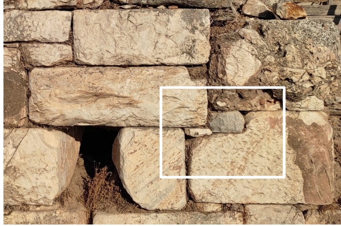
Şekil 53. Metropolis Akropolisi sur duvarlarının doğu cephesinde yeniden örme sürecinde kotları dengelemek için kullanılan küçük doldurma taşları (Kişisel Arşiv, 2022)
