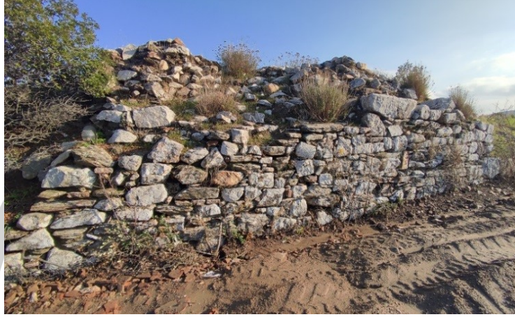
Şekil 55. Metropolis Akropolisi sur duvarlarında harçlı moloz örgü ile yeniden örülen duvar (Kişisel Arşiv, 2022)
