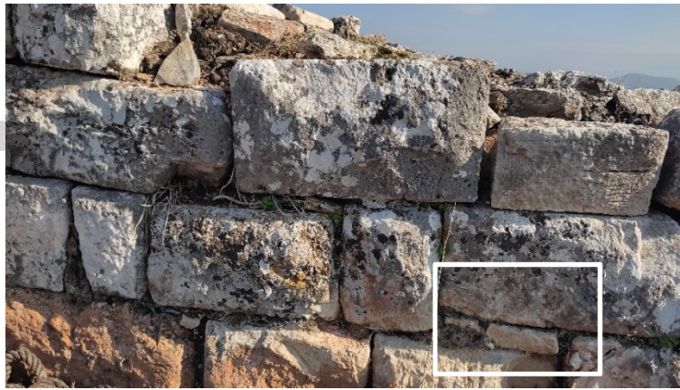
Şekil 51. Metropolis Akropolisi sur duvarlarının doğu cephesinde yeniden örme sürecinde kotları dengelemek için kullanılan küçük doldurma taşları (Kişisel Arşiv, 2022)
