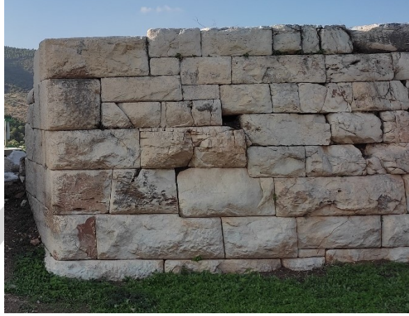
Şekil 50. Metropolis Akropolisi batı sur duvarları iç cephesinde trapeziodal kesme taş bloklar ile işlenmemiş blokların birlikte kullanımı (Kişisel Arşiv, 2022)
