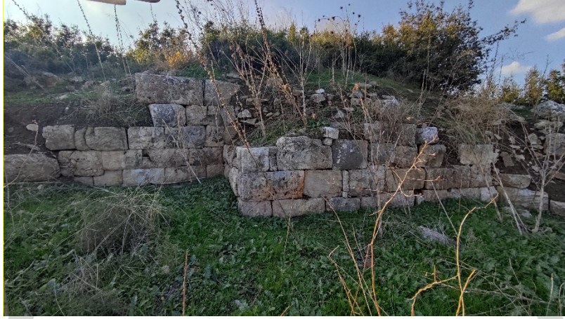
Şekil 48. Metropolis Akropolisi güneybatı sur duvarlarında isodomik örgü (Kişisel Arşiv, 2022)
