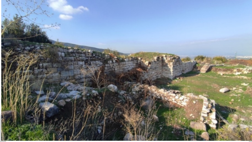
Şekil 26. Metropolis Akropolisi batı sur duvarları (Kişisel Arşiv, 2021)
