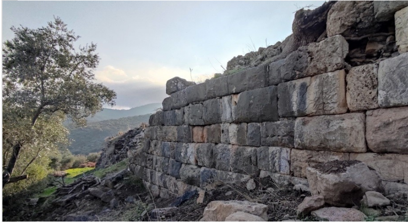
Şekil 47. Metropolis Akropolisi doğu sur duvarları dış cephesinde isodomik örgü (Kişisel Arşiv, 2022)
