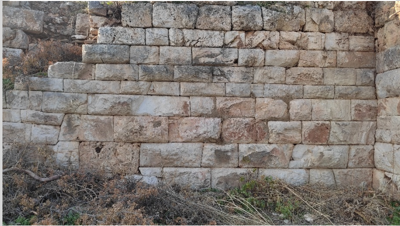
Şekil 49. Metropolis Akropolisi batı sur duvarları iç cephesinde trapeziodal, isodomik ve pseudo-isodomik örgünün bir arada kullanımı (Kişisel Arşiv, 2022)
