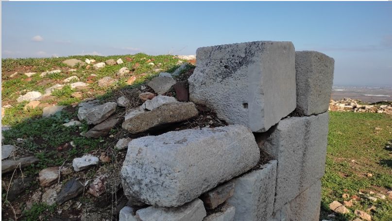
Şekil 58. Metropolis Akropolisi surlarında batı duvarlarının dış cephesinde devşirme malzeme kullanımı (Kişisel Arşiv, 2022)
