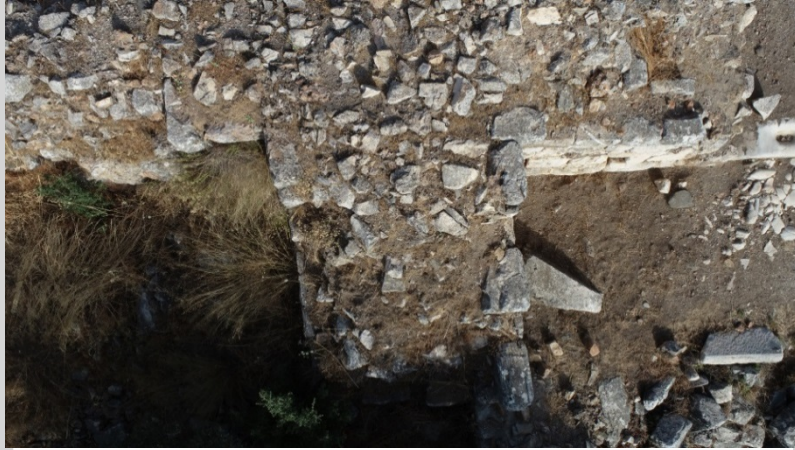
Şekil 32. Metropolis Akropolisi sur duvarlarında harçlı ve taşlı iç dolgu (Metropolis Kazı Arşivi, 2021)
