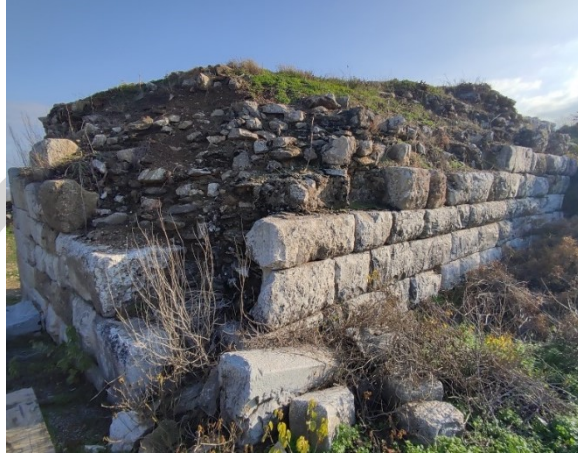
Şekil 46. Metropolis Akropolisi batı sur duvarlarının dış cephesinde isodomik örgü (Kişisel Arşiv, 2022)
