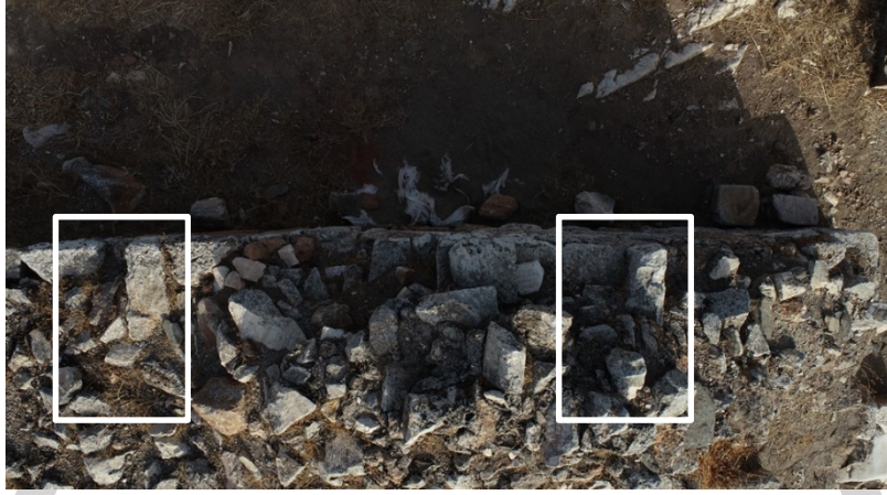
Şekil 30. Metropolis Akropolisi sur duvarlarında emplekton tekniğinde kullanılan atkı taşları (Metropolis Kazı Arşivi, 2021)
