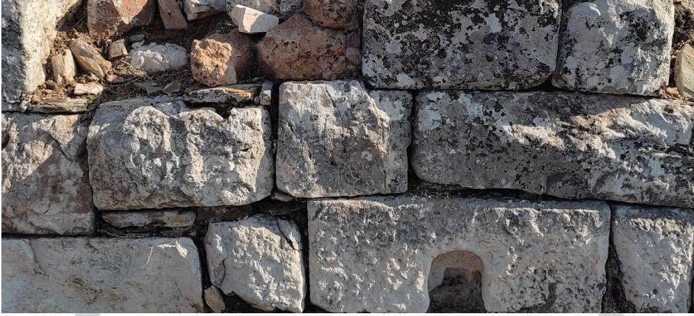
Şekil 56. Metropolis Akropolisi surlarında doğu duvarlarının iç cephesinde devşirme malzeme kullanımı (Kişisel Arşiv, 2022)
