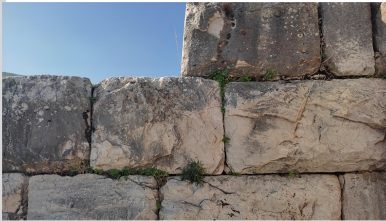
Şekil 29. Metropolis Akropolisi surlarının temel yapı malzemesi olan kireç taşı bloklar (Kişisel Arşiv, 2022)
