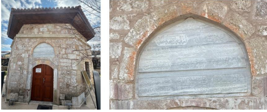
Fot. 27-28: Türbenin kuzeydoğu / giriş cephesi ve kapı açıklığı üzerindeki inşa kitabesi.
