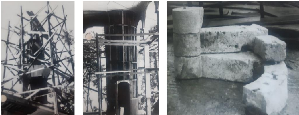
Fot. 5-7: Ahşap minarenin restorasyonu sırasındaki hâli ile minarenin özgün minare taşları (Muğla Kültür Varlıklarını Koruma Bölge Kurulu Müdürlüğü Arşivinden).
