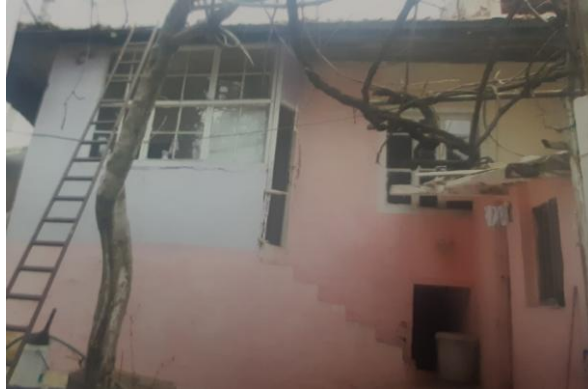
Fot. 12: İmam evi olarak kullanılan yapının giriş cephesinden görünümü (Muğla Kültür Varlıklarını Koruma Bölge Kurulu Müdürlüğü Arşivinden).
