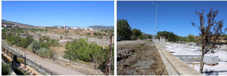
Şekil 8. Millet Bahçesi inşaatından kesitler
