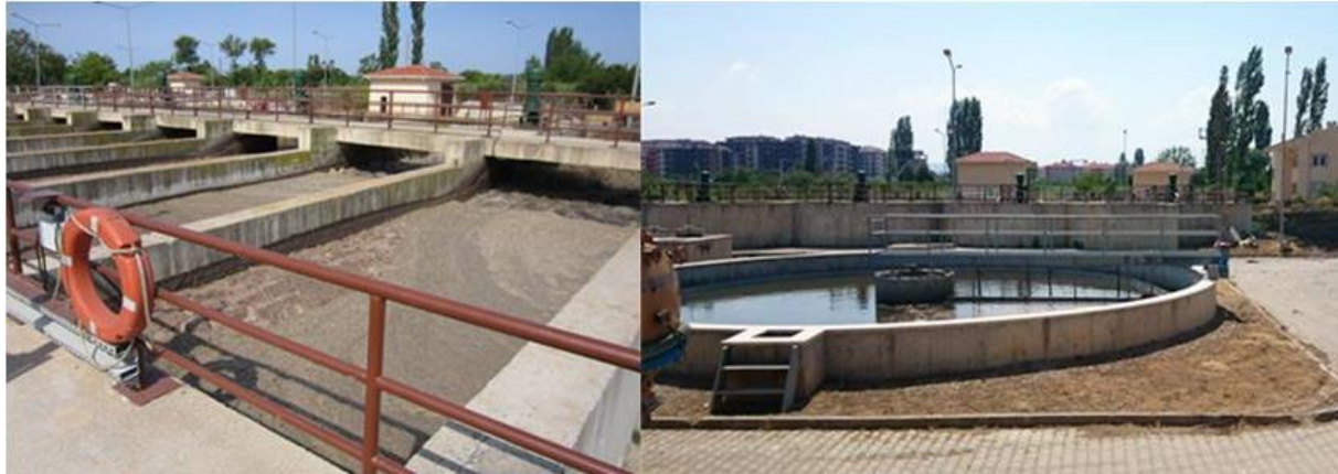
Şekil 2. Kepez Atık Su Arıtma Tesisleri
