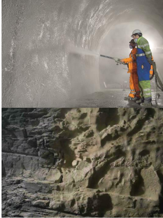
Şekil 2. PİK ürününün uygulaması ve uygulanmış hali [27]
