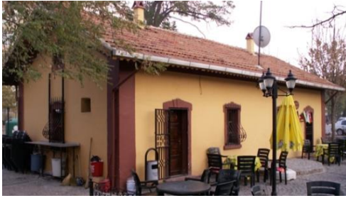
Şekil 16. Makasçı binası, peron cephesi
