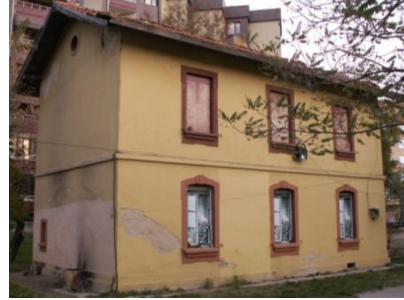
Şekil 21. Fen memuru binası, peron cephesi
