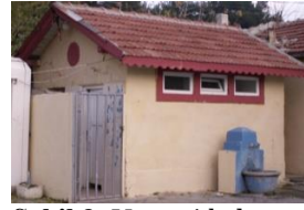
Şekil 9. Umumi hela, peron cephesi
