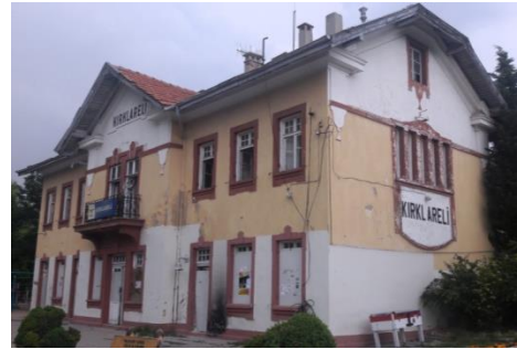
Şekil 12. Yolcu binası, peron cephesi
