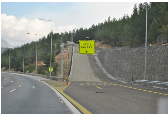
Şekil 1. Tarsus-Pozantı otoyolundaki 1 nolu kaçış rampasının genel görünümü
