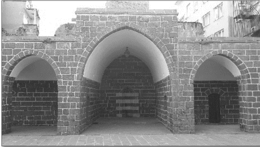
Şekil 8. Kuzey Cephesinden Görünüş
