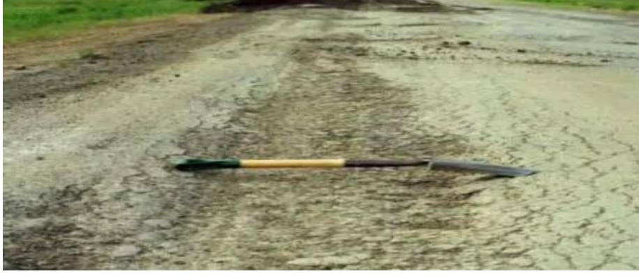
Şekil 1. Drenaj yetersizliğinden kaynaklı oluşan oturmalar
