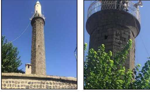
Şekil 8.Hoca Ahmet Cami minaresinde harç kaybı ve ayrışmaya bağlı oluşan yapısal sorunlar
