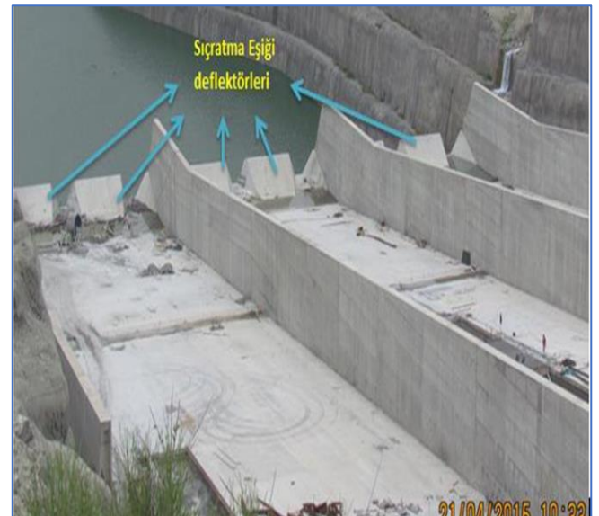
Şekil 5. Dişli Sıçratma Eşiği (Slotted Bucket)
