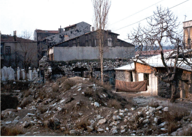
17. Şeyh Vefa Medresesi İç Görünüşü, Yapıyı Gecekondular İstila Etmıştır.
