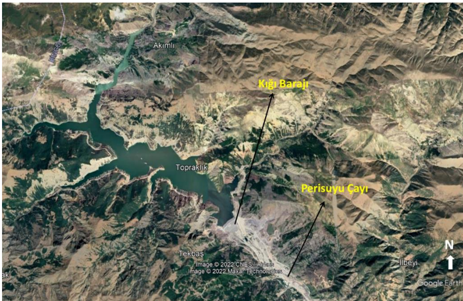
Şekil 2. Kiğı Barajı (Google Earth, 2022).
