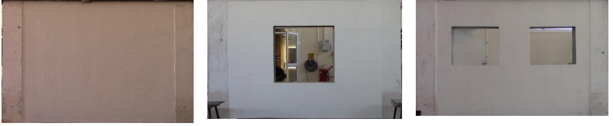
Şekil 9. Deney Başlangıcında betonarme çerçevelerin dolgu duvarları.
