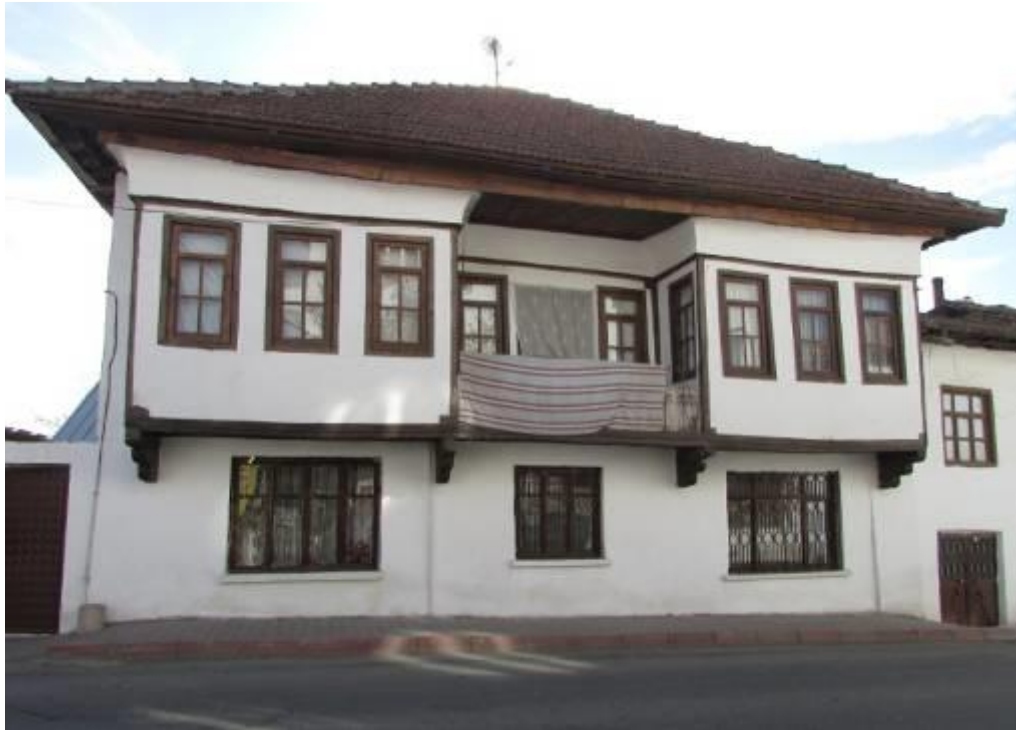
Şekil 15. Oda Boyu Kapalı ve Açık Çıkma(6 No'Lu Ev)
