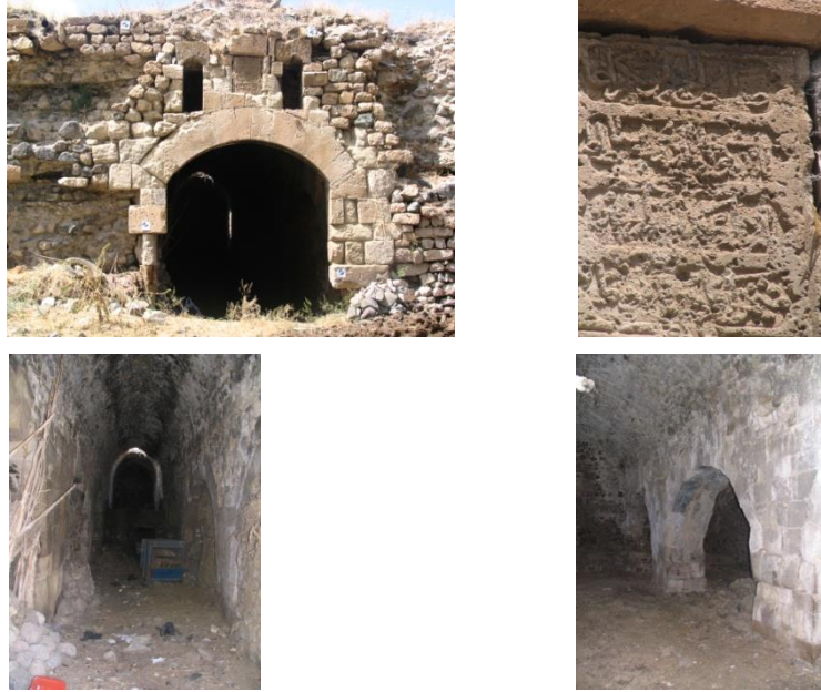
Şekil 3. Cephe ve İç Mekân Fotoğrafları 12
