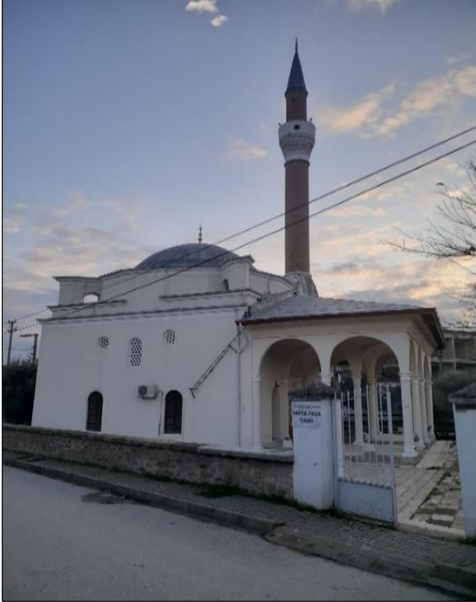
Resim-I /Yahya Paşa Cami Genel Görünüm
