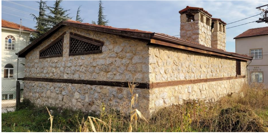
Foto. 10. Çamaşırhanenin güneybatı köşeden görünümü
