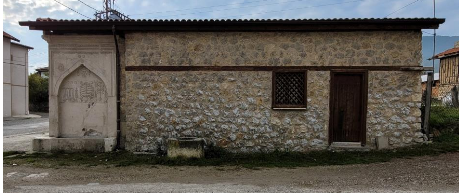
Foto. 8. Kuzey cepheden görünüm
