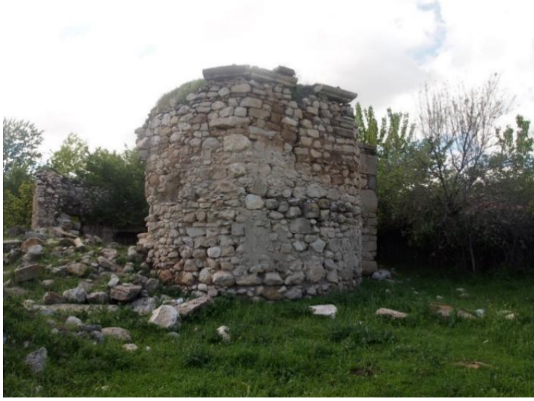
Foto 19. Surp Kevork Kilisesi, Genel Görünüşü.
