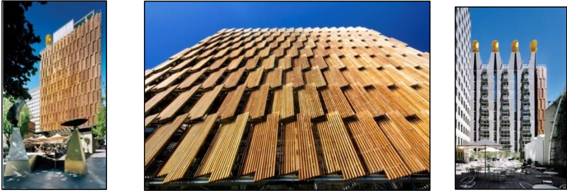
Şekil 9. Farklı açılardan CH2 binası [27]
