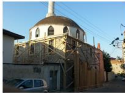
b. Güney cephe
