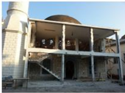
a. Kuzey cephe
